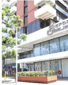
REFORMA OBELISCO Apartamento ubicado en la Avenida Reforma 15-54, zona 9
